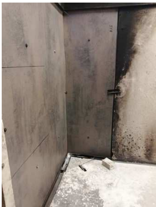
Figura 1 – Montagem dos provetes.
